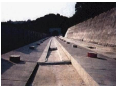
写真 - 2 路盤突起コンクリート
