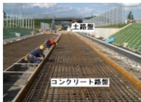
写真 - 1 コンクリート路盤と土路盤
