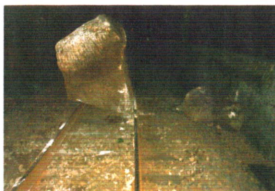
写真-2 落石による被害
