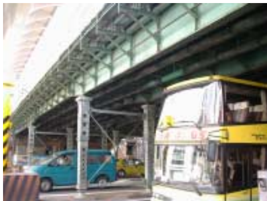
写真 - 1 センサー設置橋梁（呉服橋）
