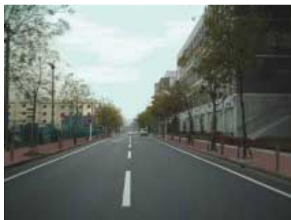
写真 - 2 ボラード、カラータイル歩道、電柱無しの例
