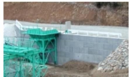
写真 - 1 完成状況（骨材投入設備）
