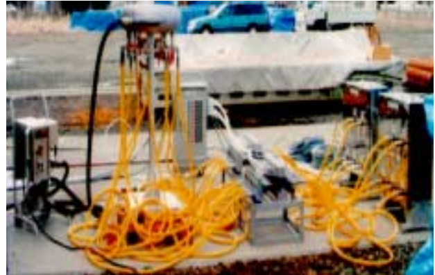
写真-2 三次元同時注入システム （ハイパ-グラウトシステム）
