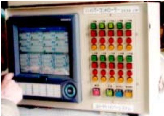
写真-1 三次元同時注入管理システム （ハイパ-グラウトコントローラ）
