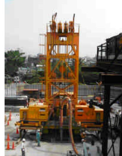
写真1 連続壁施工状況
