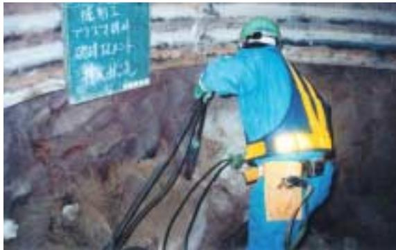
写真 - 2 破碎エレメント挿入状況
