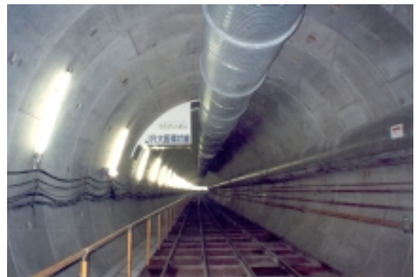
図-6 施工状況写真(JR 下付近)
