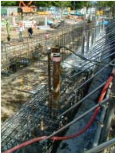
写真1 壁内井戸設置状況
