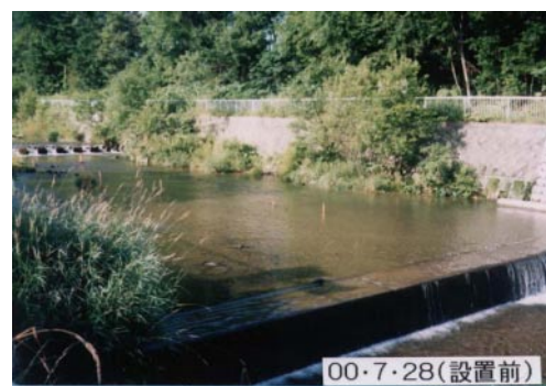
写真-1 試験水路施工前の状況
