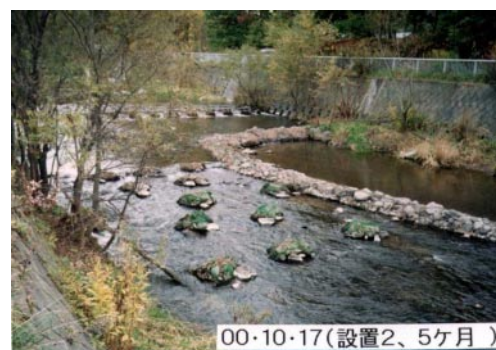
写真-2 施工後の状況
