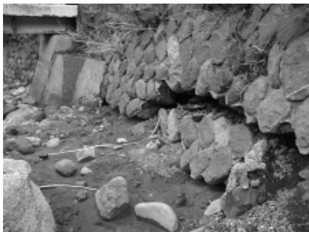
写真-3 揺動作用により崩落したと推定される護岸
