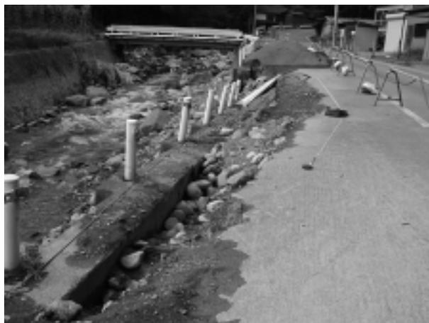
写真-1 典型的な被災状況（応急復旧として背面に玉石が詰めてある）
