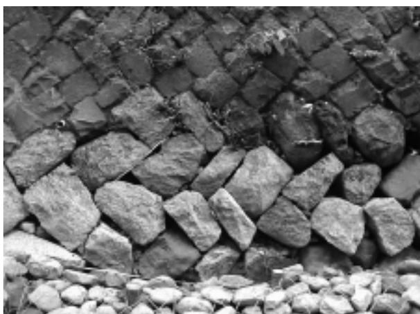
写真-2 背面土が吸い出され変形した護岸
