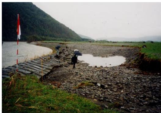
写真-1 洪水時に形成された砂州による深掘
