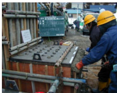
写真 - 3 スペーシング状況
