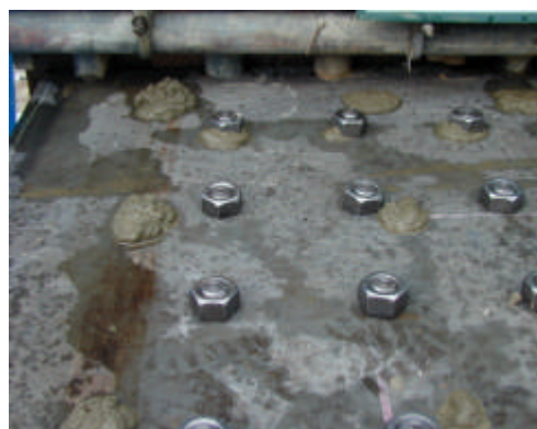
写真 - 2 ブリーディング水排出状況
