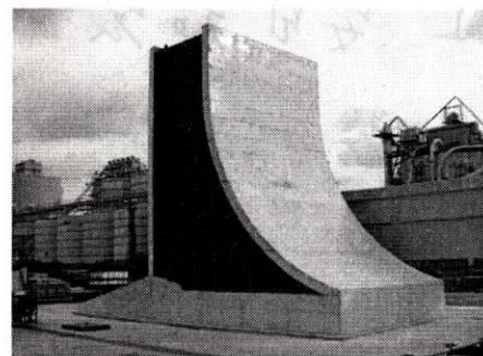
図4 コンクリート打設完了後の状態
