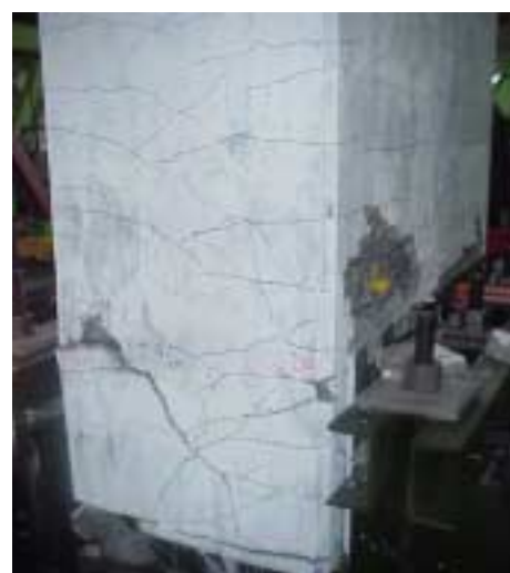
写真-2 コンクリートの破壊状況
