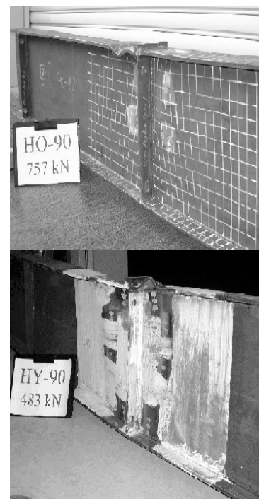
Photo.1 座屈後供試体 (幅厚比 90 タイプ)
