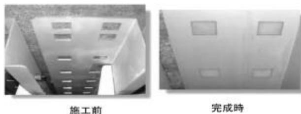
図2．床版と薄鋼板部材との接着
