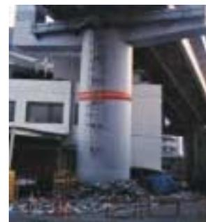
写真-1 局部座屈損傷の例
