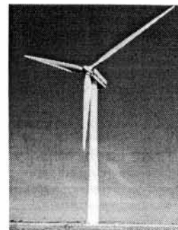
図-1 風力発電施設
