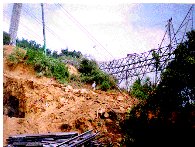
写真-1 倒壊した345kV超高圧送電鉄塔(中寮～峨眉間の#203)
