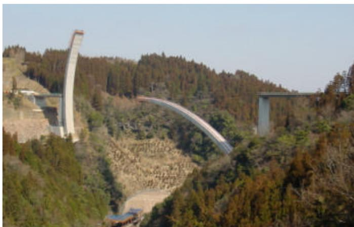
写真-1 ロアリング架設状況
