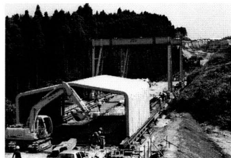
写真-1 床版製作ヤードの全景
