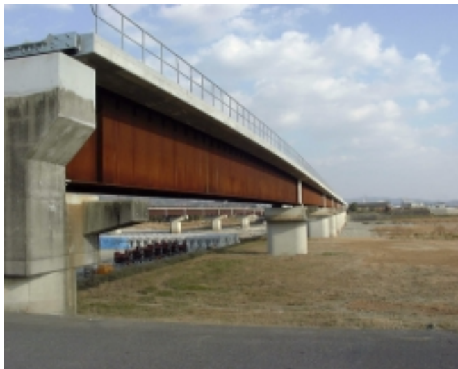
写真－1 調査橋梁（物部川橋梁）
