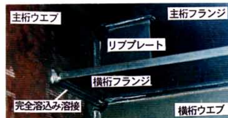
写真-1 横桁取合部
