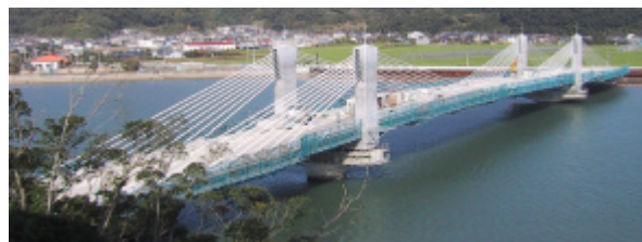
写真 - 1 佐敷大橋全景
