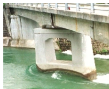
写真 4 橋脚上下流付近の流れの様子
