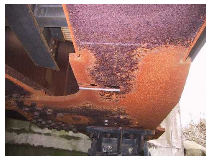
写真2 No.11 橋の下弦材下フランジ下面
