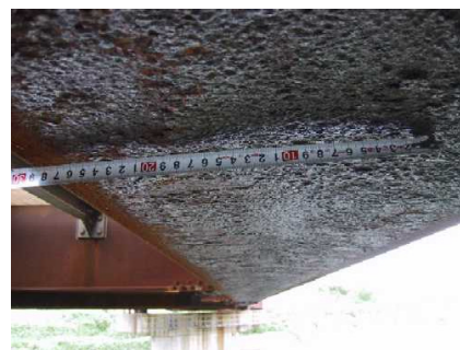
写真1 No.12 橋の主桁下フランジ下面
