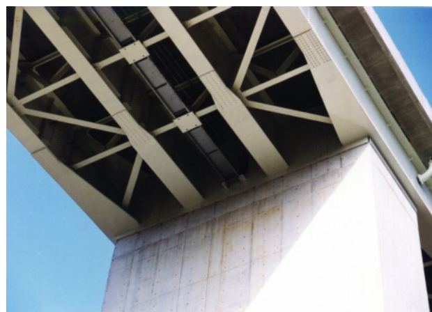
写真-1 剛結部の構造
