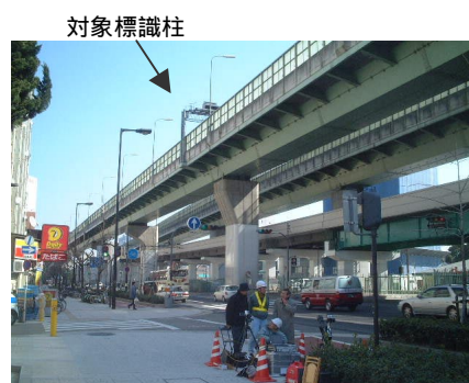
図-2 振動測定の全景
