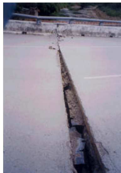
写真 - 3 卓欄方面線 P1 上のけたの回転変位
