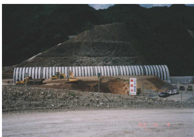
図-6 アーチ部材架設状況
