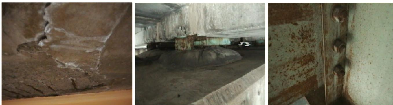
a) 床版の損傷状況                      b) 支承部の損傷状況                      c) 接合部の損傷状況
