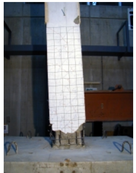
写真 - 1 破壊状況
