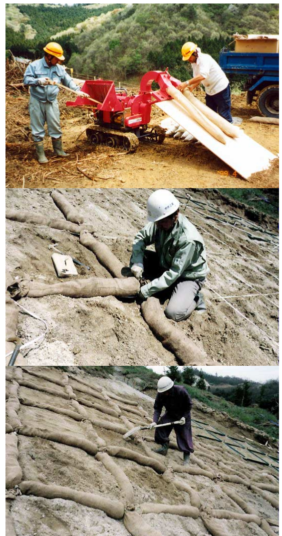
図 2 エコ法枠の施工状況
