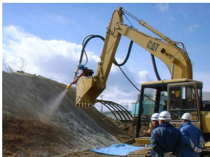
写真-1 吹付け状況写真
