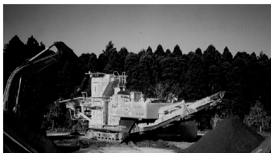
写真－1 自走式土壌混合プラントによる混合攪拌
