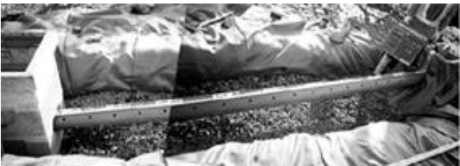
施工状況写真
