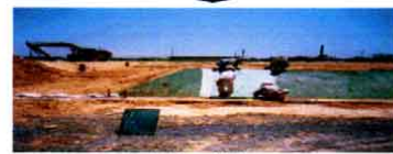
シート張り状況
