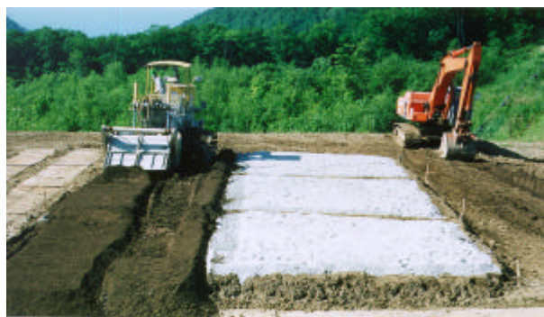
写真 - 1 混合状況
