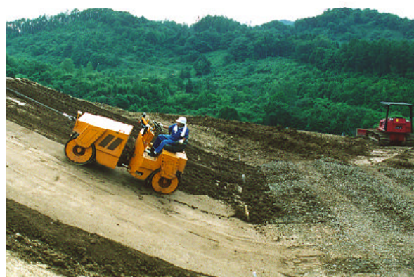
写真 - 2 法面部転圧状況
