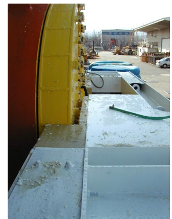
写真—2 条件 2 切削状況
