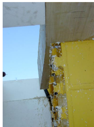
写真—1 条件 1 切削状況
