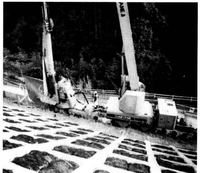
図－4 抑止杭の圧入状況
