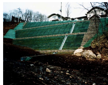
写真-3 復旧完了
