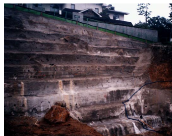
写真-2 鉄筋補強土
