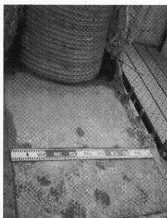
図 7 実大モデル実験 (下部から打設)
