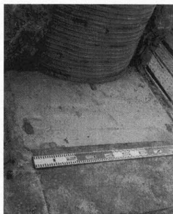
図 6 実大モデル実験 (上部から打設)
