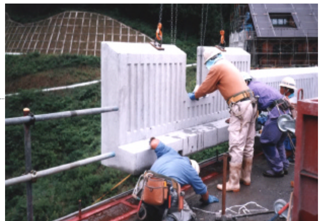
写真-1 プレキャスト高欄据付状況
