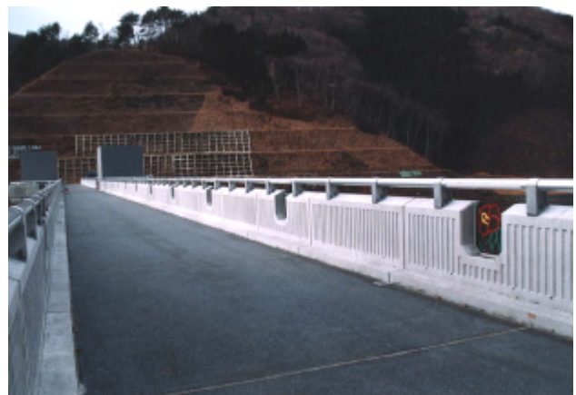
写真-2 プレキャスト高欄完成状況
