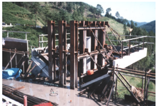
写真－2 建込み完了（水位計測塔）
