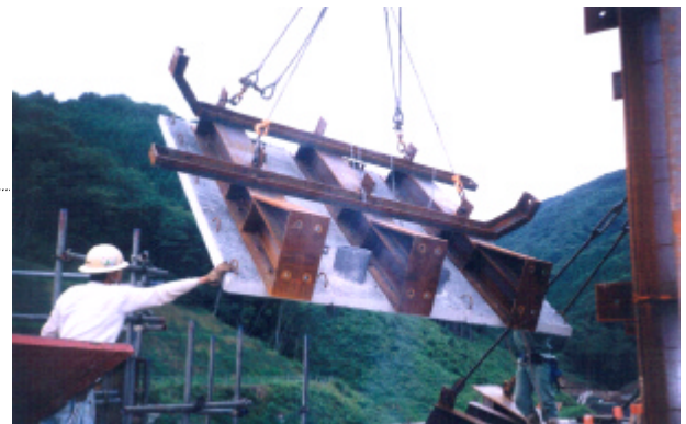
写真－1 建込み状況（取水塔）
