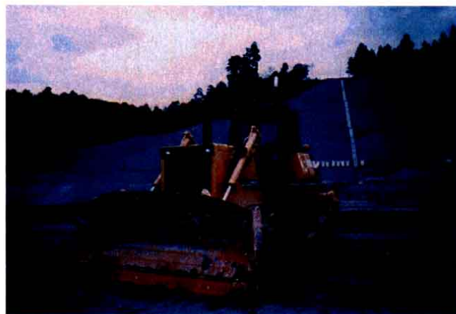
写真—1 GPSを搭載したブルドーザ
