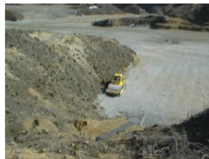
写真 - 1 A地点の状況
