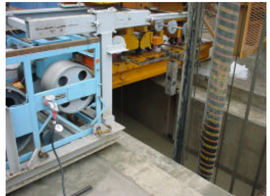
写真 - 1 実施工での溝壁計測状況
