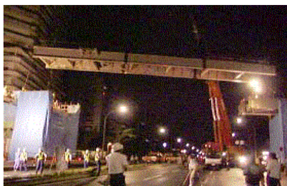
写真 - 2 鋼主桁架設状況
