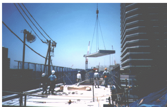
写真 - 3 プレキャスト床版架設状況
