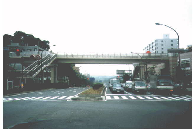
写真 - 1 完成全景
